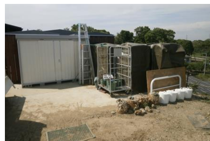
ストックヤード整備
