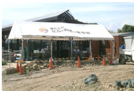
石割場テント設置
